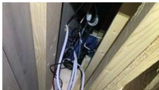
Inspeksjonsmulighet bad toalett.
