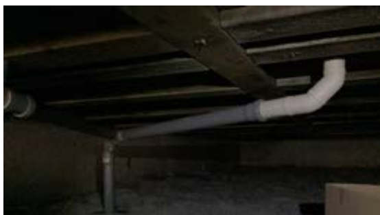
Inspeksjonsmulighet fra krypekjeller.
