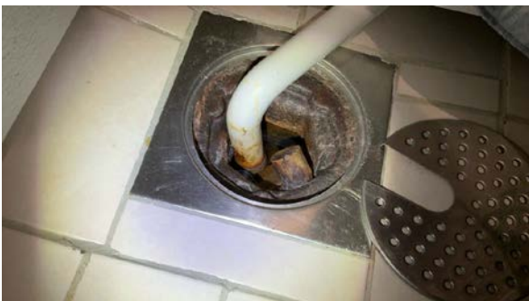
Sluk bad i utleieenhet.
