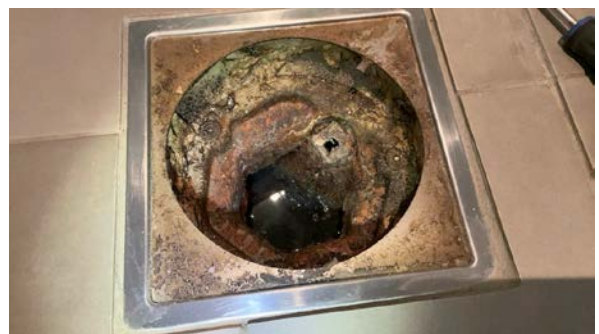
Sluk bad ved soverom i 1. etasje
