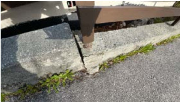
Støttemur mot garasje
