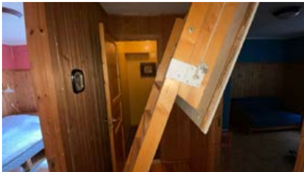
Tilkomst via uisolert loftsluke med nedtrekkbar stige.
