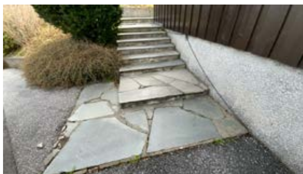
Skiferbelagt trapp til inngangsparti.
