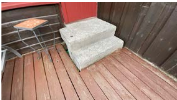
Plasstøpt trapp fra stue ned på terrasse.
