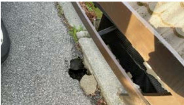
Støttemur mot garasje.
