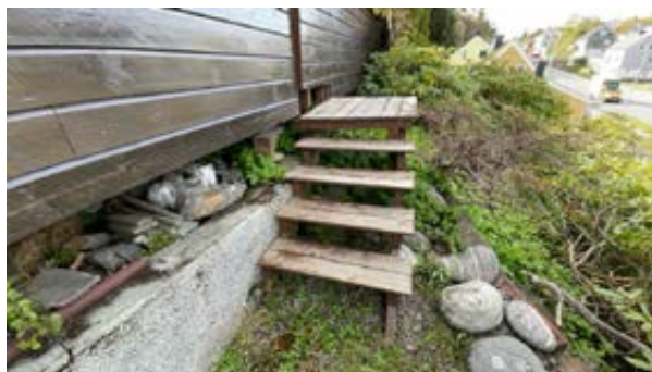
Enkel åpen tretrapp fra terreng opp til terrasse.
