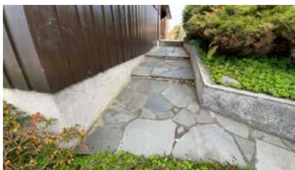
Skiferbelagt trapp til inngangsparti.
