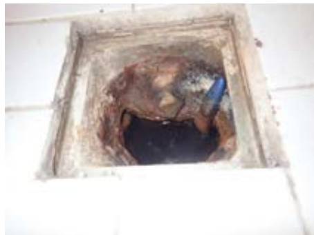
Eldre jernsluk - uten klemring. Ikke synlig membran.
