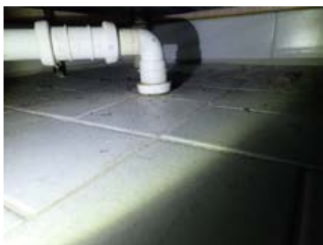
Direkte avløp fra dusjkabinett via avløpsrør i gulv.
