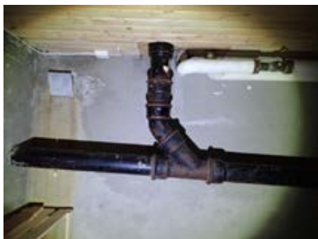
Soilrør som avløpsrør
