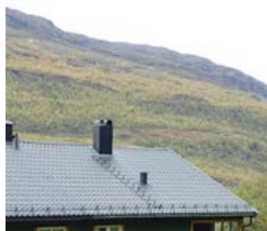
Snøfanger, stigetrinn til pipen
