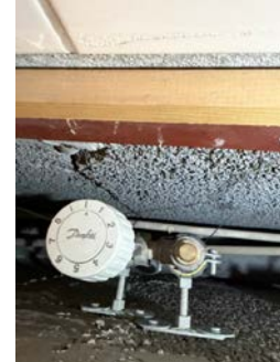
Justering av vannbåren varme i baderomsgulv
