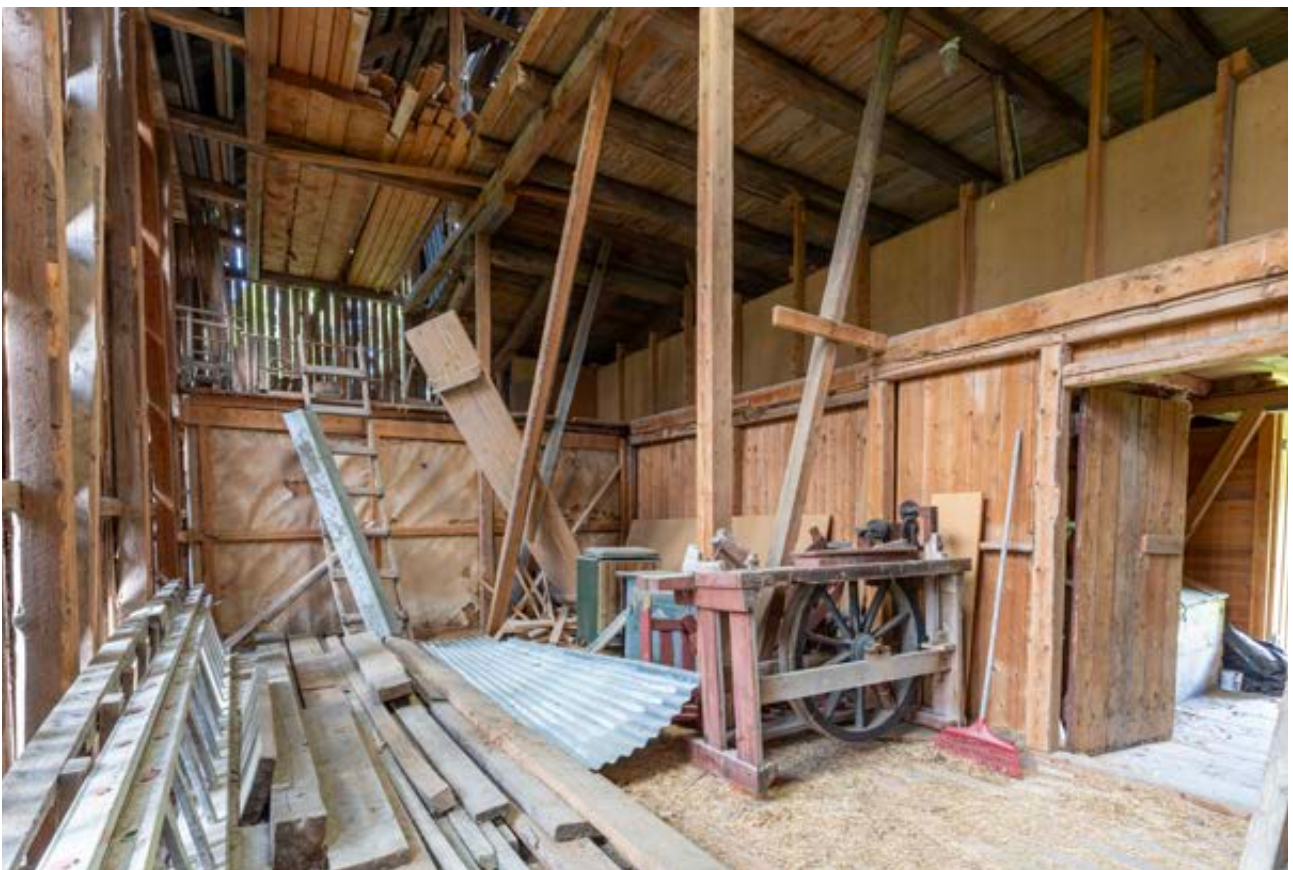
Første etasje i driftsbygningen har enkel adkomst og god takhøyde, noe som gir fleksible bruksmuligheter og potensial for ulike typer innredning.
