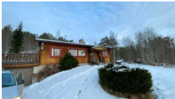
Snødekt tak ved dagens befaringsdag.
