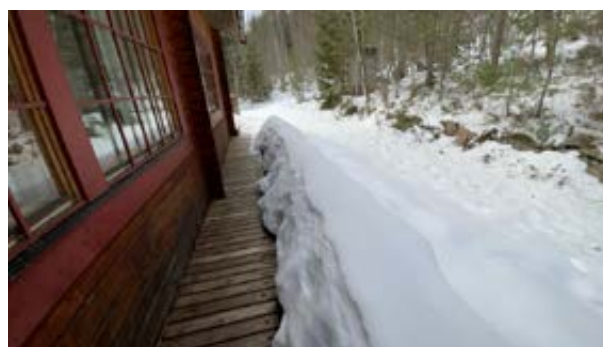
Bilde av baksiden mot nord.
