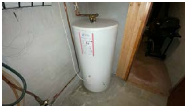
Varmtvannsbereder
