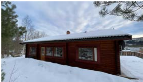
Snødekt tak ved dagens befaringsdag.
