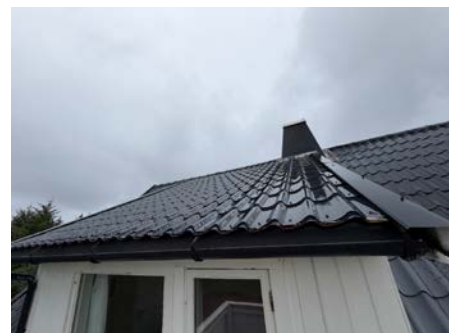
Oversiktsbilde av takteking, besiktiget fra veranda.
