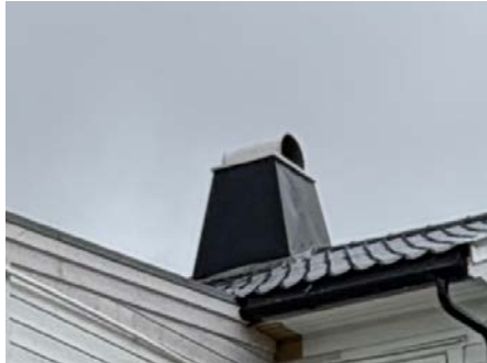
Skorstein over tak.
