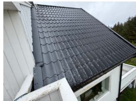
Oversiktsbilde av takteking, besiktiget fra veranda.
