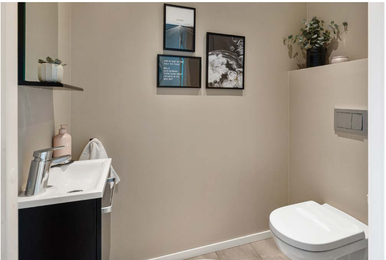
Toalettrom med flislagt gulv og malte, glatte overflater på vegger og himling. Gulvvarme bidrar til økt komfort. Rommet er utstyrt med vannklosett og servant med underskap, samt speil og belysning.
