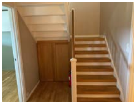
Innvendig trapp mellom etasjene.
