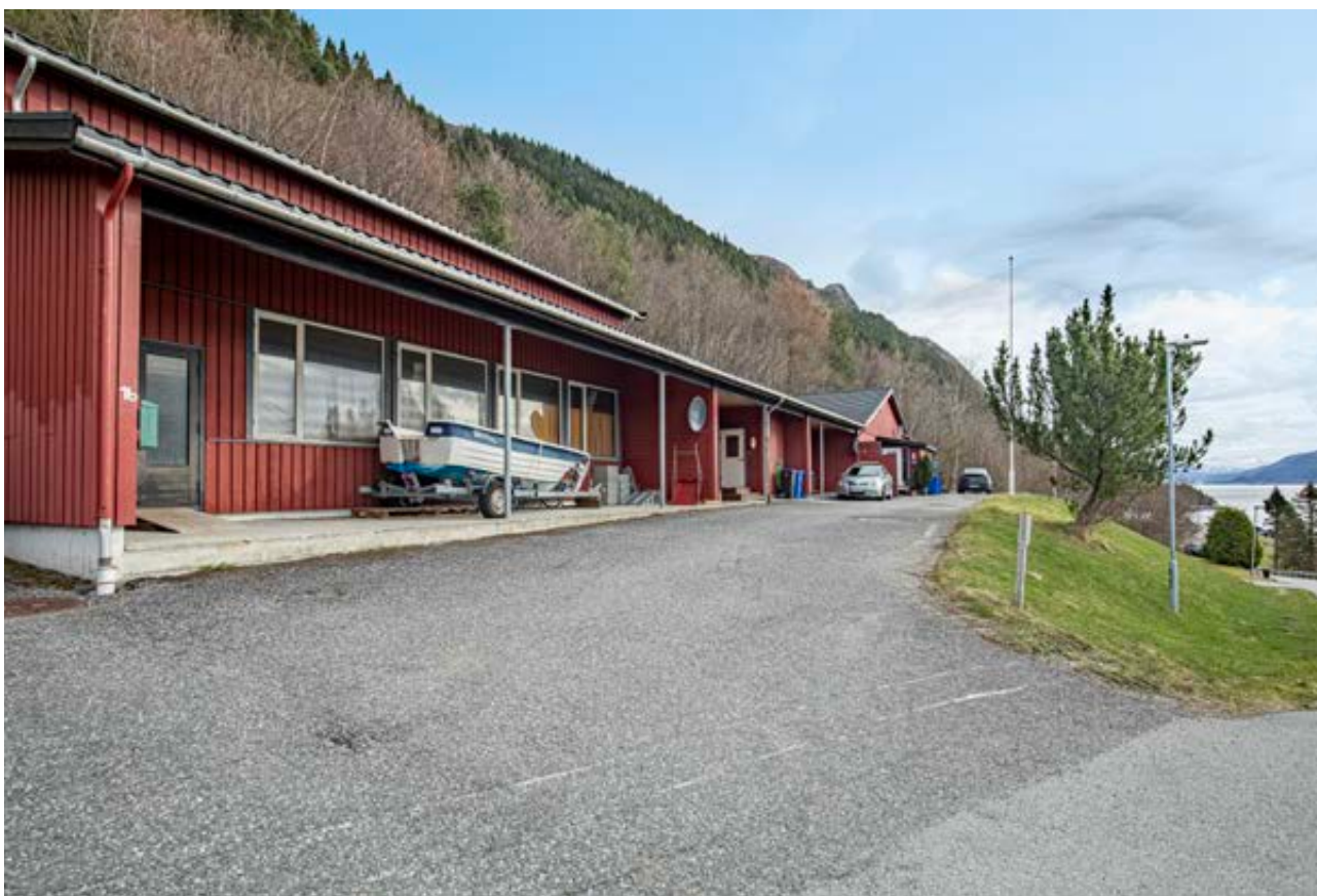
Bygget ble godkjent ombygd til 6 leiligheter, men bare 4 av disse ble bygget | tidligere gymsal ble i 1998 også omsøkt innredet til 2 leiligheter, men disse ble ikke bygget
