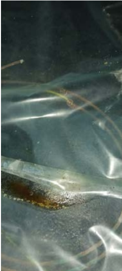
Bilde 1 Jordleder fra jordelektrode til sikringsskap ligger løst.
