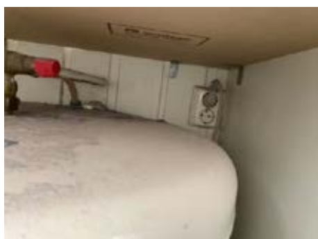
Dagens løsning er via stikkontakt, anbefaler fast tilkobling.
