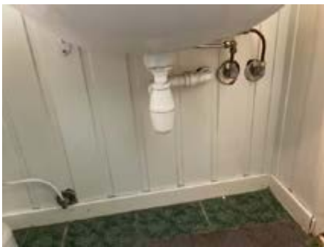
Avløp i plast Rørøpplagg i metall
