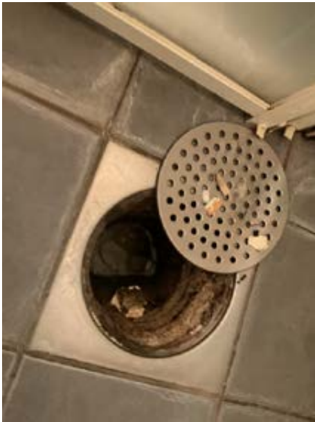
Sluk uten membran/mansjett
