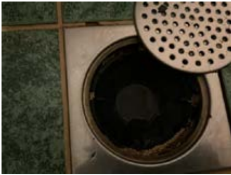
Sluk uten membran/mansjett
