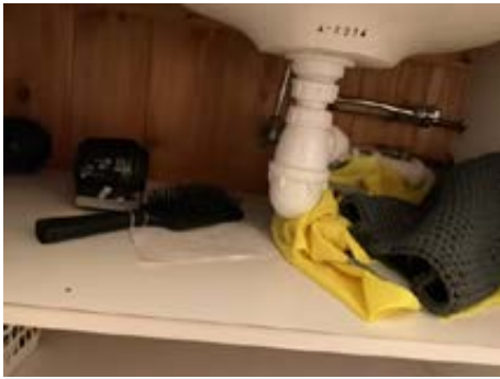
Avløp i plast Rørøpplegg i kobber
