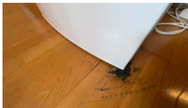
Lekkasje fra kjøleskap.
