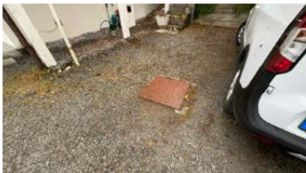
Nedgravd oljetank.
