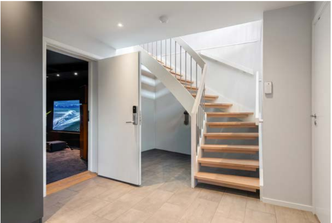
Trapp til andre etasje har sikkerhetsrekkverk på begge sider.
