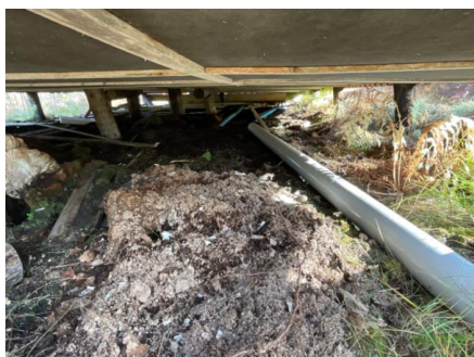
Oversikt krypkjeller sett fra utsiden
