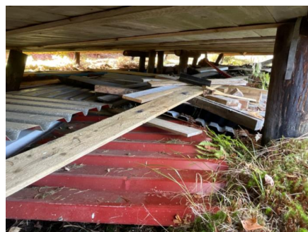
Oversikt krypkjeller sett fra utsiden
