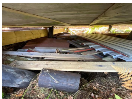
Oversikt krypkjeller sett fra utsiden
