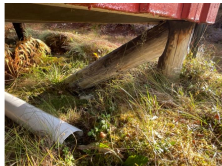
Det er satt opp støtter på hjørner ved byggeår
