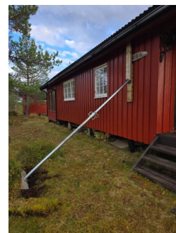
Det er satt opp støtter på hjørner ved byggeår
