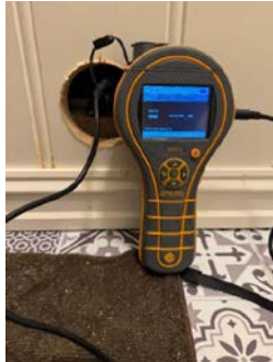
Fuktmåling i hulrom i veggen bak dusjen.
