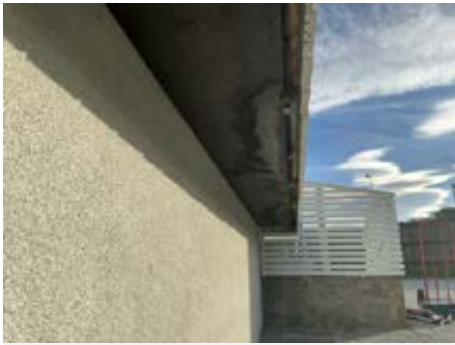
Arbeid under utbygg er ikke ferdigstilt.
