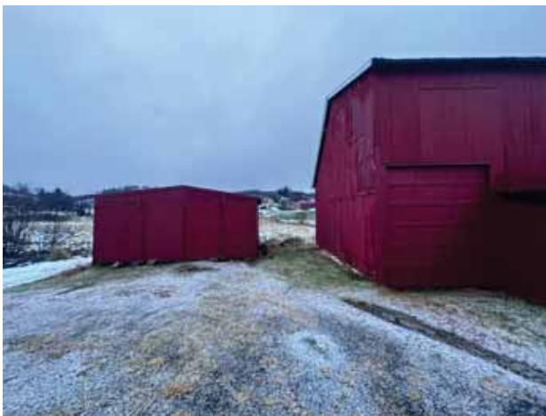
Garasje og driftsbygning
