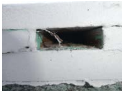
Musesperre må monteres på hulrom bak kledning
