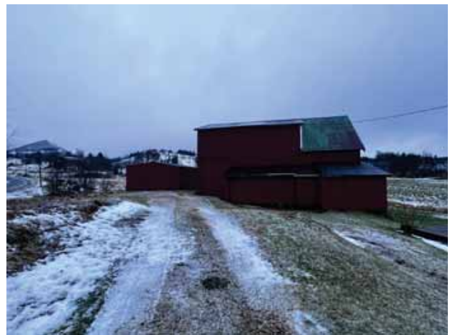
Garasje og driftsbygning
