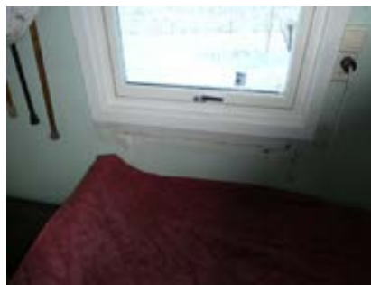
Gammel fuktskade under vindu på soverom sør side
