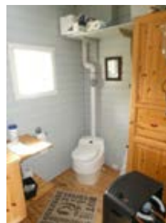
Hyttetoalett med lufting over yttertak
