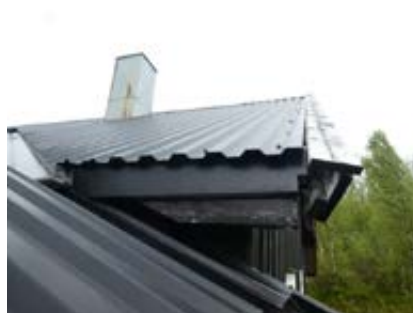
Vindski må overflatebehandles og festes tilstrekkelig
