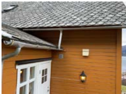
Deformasjoner/heng takrenne
