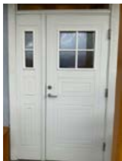
Entre kjeller med sidefelt og overlys
