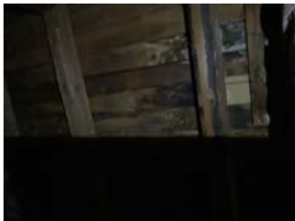
Fuktskjolder, ikke tilkomst til å måle
