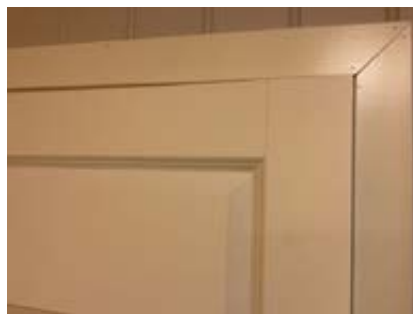
Dør mellom lager og bakgang tar i karm
