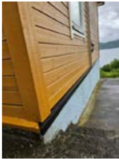
03.07.25: Bilder etter utbedring vannbord/beslag overkant mur, nordvest
