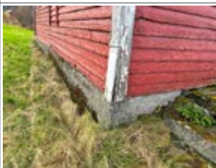
Råteskader
