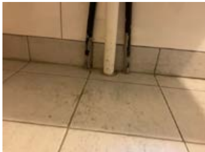
Rørgjennomføringer gulv
