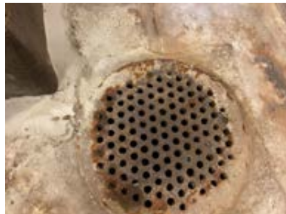
Trekker fra større gulvsluk, kan være åpen steingrøft eller lignende
