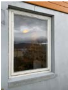
Kjellervindu uten beslag under og avvik på fuger
