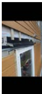
Kjellervindu uten beslag under og avvik på fuger
