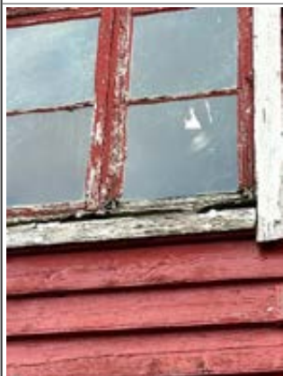
Råteskade vindu
