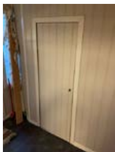
Enkel kottedør mellom bod øst og entre hovedetasje
