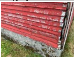
Råteskader
