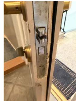
Bruksmerker/småskader i entredøren.
