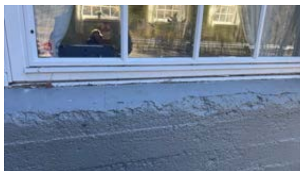
Feil sålebenker i de fleste vinduer montert i grunnmur (murspiss ført opp på vinduernes bunnkarm)
