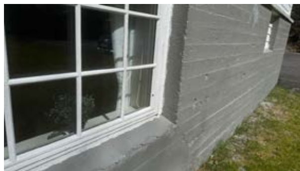
Noen vinduer kan være brukbare.
