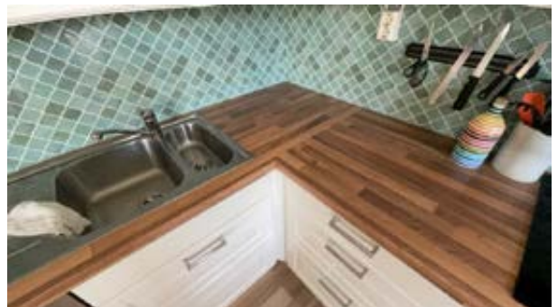
VVs bereder er integrert i underskap i hjørne på kjøkkeninnredningen.
