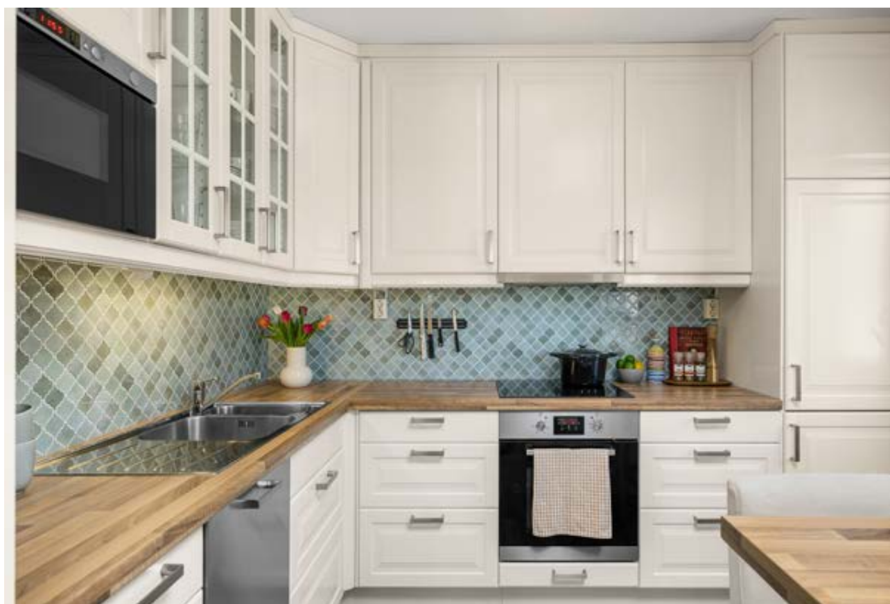
Heltre benkeplate med nedfelt oppvask/skyllekum og ett-greps armatur.
