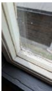
Vinduene i hytta har kort gjenværende levetid.
