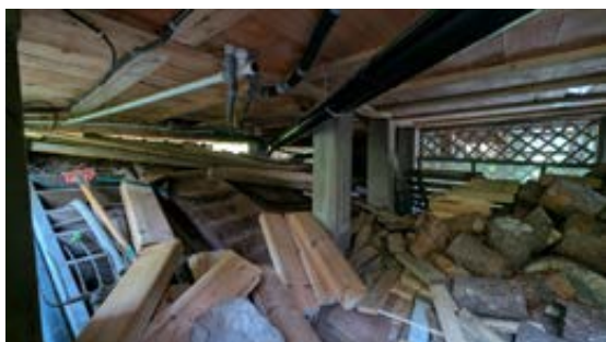
Bjelkelag sett fra undersiden.
