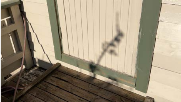
Feilmontert belistning på dørterskel.
