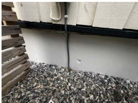
Strømkabel til jacuzzi som mangler beskyttelse.
