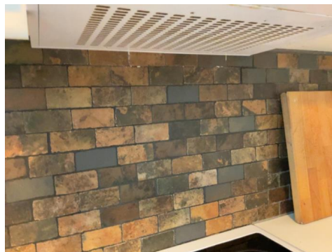
Flis på vegg over benkeplate.
