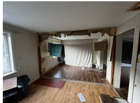
Oversiktsbilde av 2. etasje.
