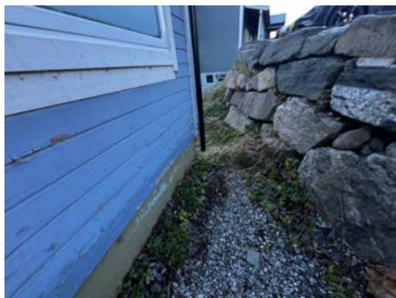
Eksempel på taknedløp som er avsluttet over terreng.
