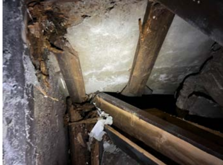
Råteskadet kjellertrapp.
