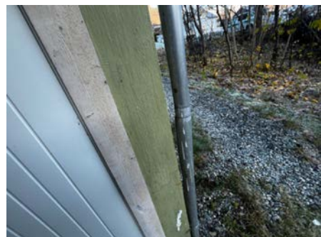
Skadet/frostsprengt taknedløp.
