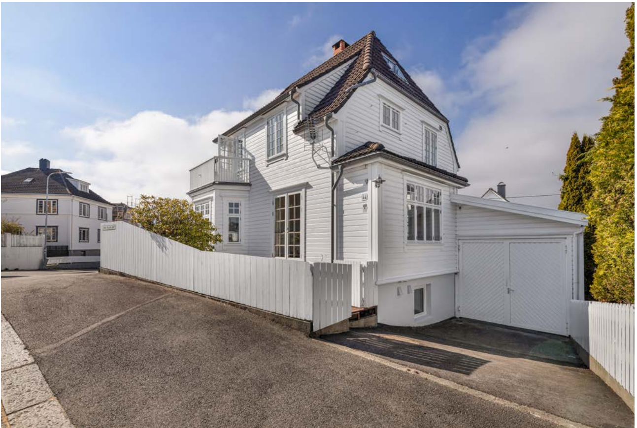
Fasade - parkering i garasje
