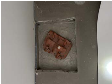
Tilbakeslagsventil på hovedavløp er tilgjengelig for vedlikehold. Jordingsmuffe på avløpsvann er montert innestøpt under kjellergulv.
