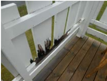
Råteskade på deler av rekkverk
