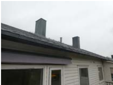
Markiser ved terrasse
