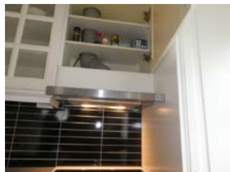
Uttrekk ventilator tar borti sideliggende skap
