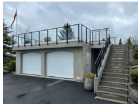
Støpt trapp opp til terrasse garasjetak
