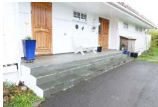
Støpt trapp/plate med skiferflis.
