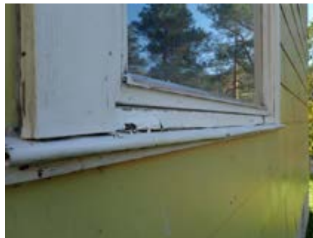
Råteskadet vindu
