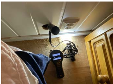
Hulltaking og fuktsøk.
