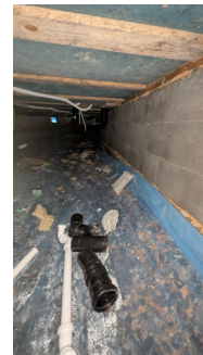
Oversiktsbilde av krypkjeller og avslutning av plast.
