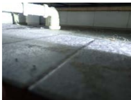
Rom under dusjkabinett. Direkte avløp via rør gjennom gulvet
