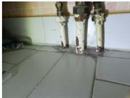
Utett rørgjennomføring
