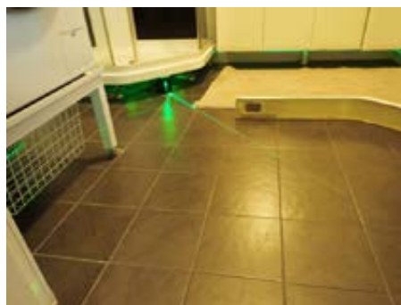
Laser på slukrist under dusjkabinett. Laserhøyde 10 cm
