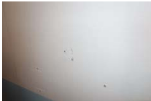
Hull etter innfestinger.
