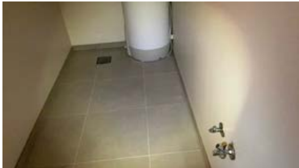
Vaskerom i 1. etasje
