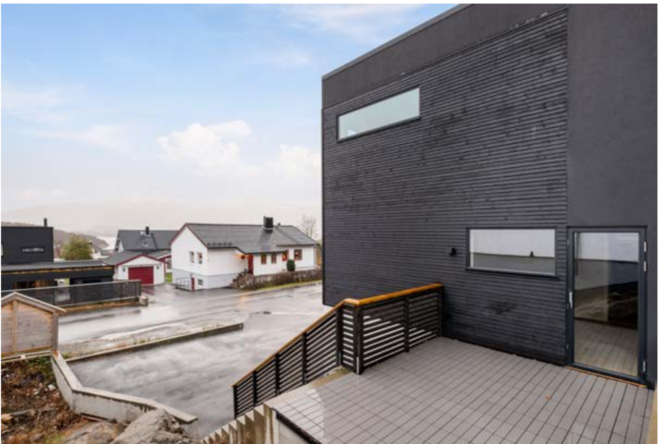
Støpt terrasse mot øst
