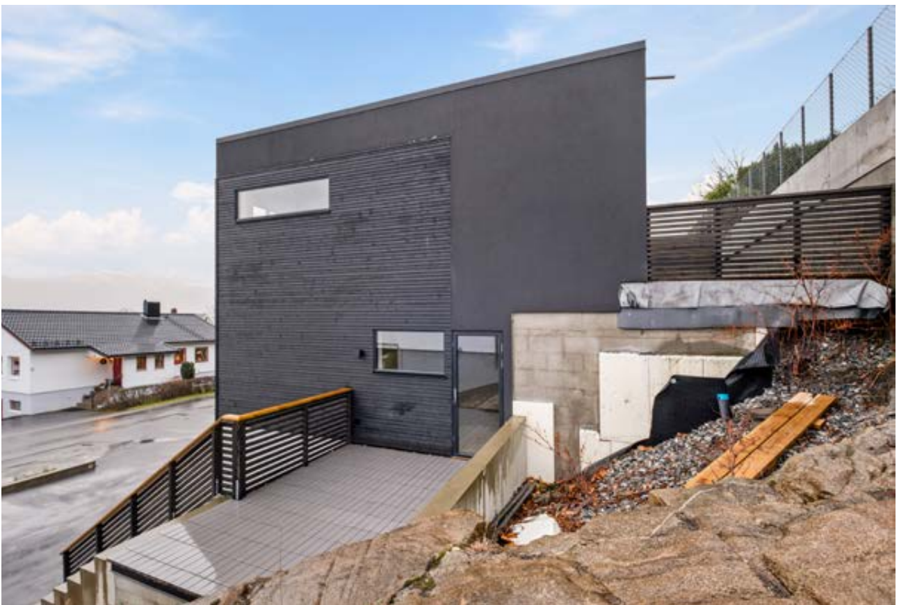
Støpt terrasse mot øst
