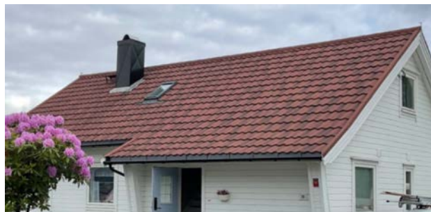
Takvinkel mellom 35 til 40 grader, uten snøfangere.
