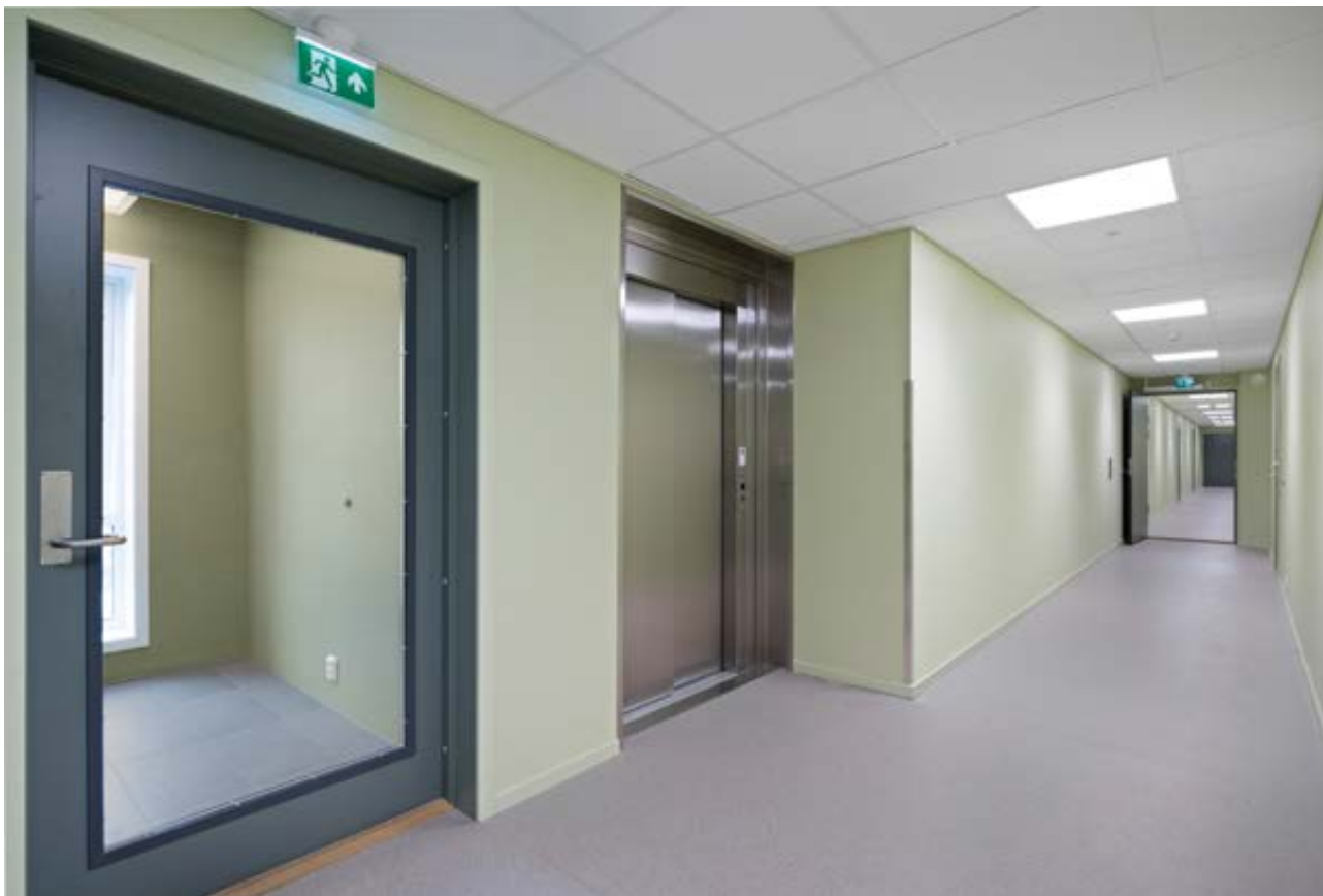
Det er heis i bygget. Man kan altså kjøre bilen inn i garasjeanlegget og ta heisen tørsodd opp til tredje etasje
