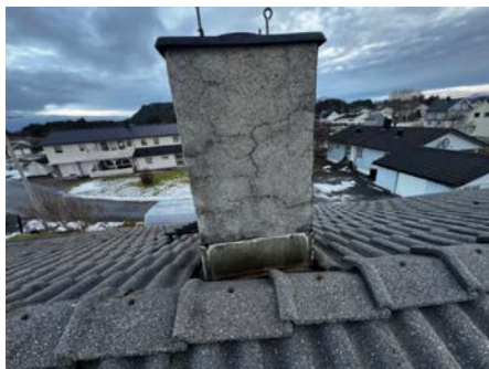
Oversiktsbilde av skorstein over tak.
