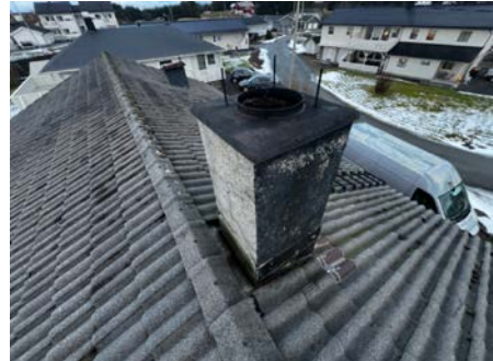
Oversiktsbilde av skorstein over tak.
