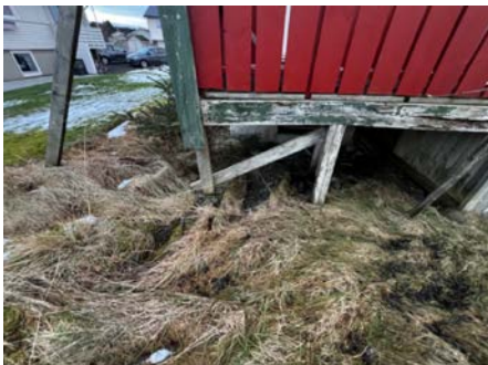
Fundamentering til veranda med utgang fra soverom.
