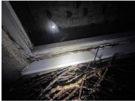
Råteskadet kjellervindu.
