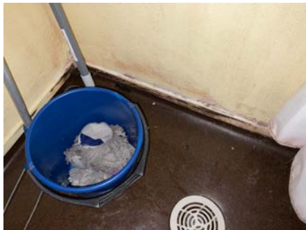
Det ble tatt hul i denne vegg i fra soverommet.
