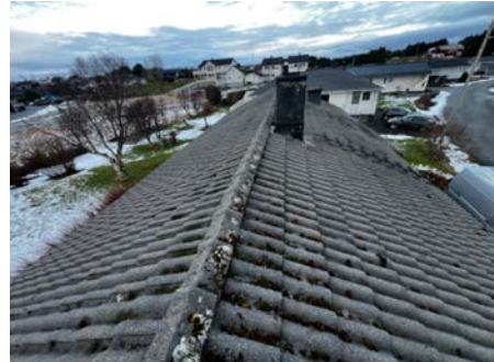
Oversiktsbilde av taktekkning.
