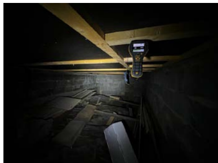
Fuktmåling, ikke over grenseverdier.
