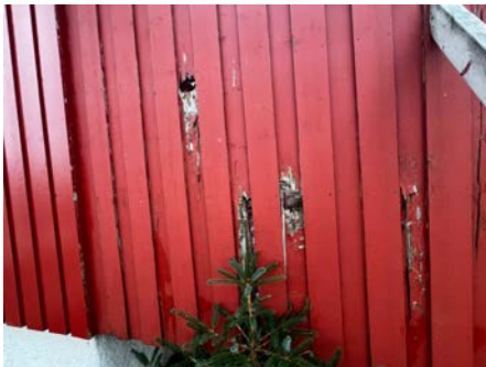
Levegg til veranda med utgang fra soverom.
