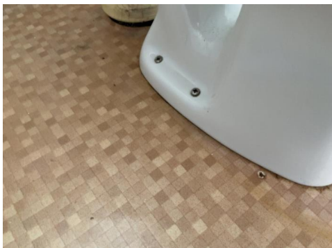
Punkttert tettesjikt ved innfestning av frittstående toalett.
