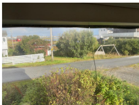
Flere punkterte vinduer i boligen.
