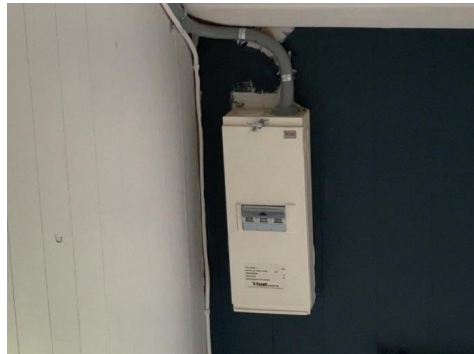
Oppgradert inntakssikring.
