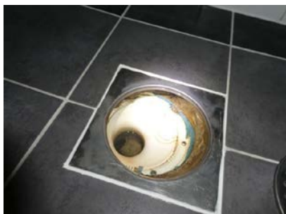
Sluk i dusjnisen - mineralproduktet er ikke i ført under klemringen,
