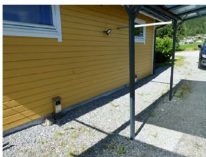
Kledning og ventilasjons åpninger i forhold til terreng
