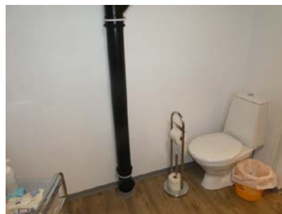
Stakeluke ved gulvet
