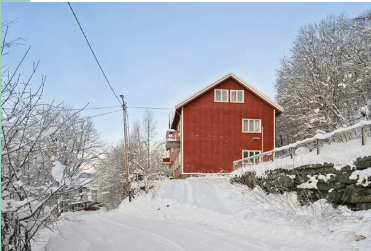
Innkjørsel til Verkstedhaugen 3
