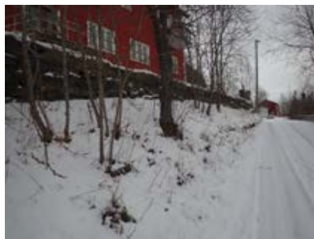
Forstøtningsmur i naturstein
