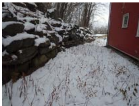
Forstøtningsmur i naturstein - øvre side.
