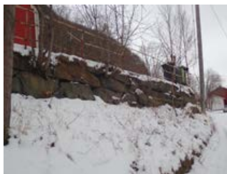
Forstøtningsmur i naturstein m/rekkverk.
