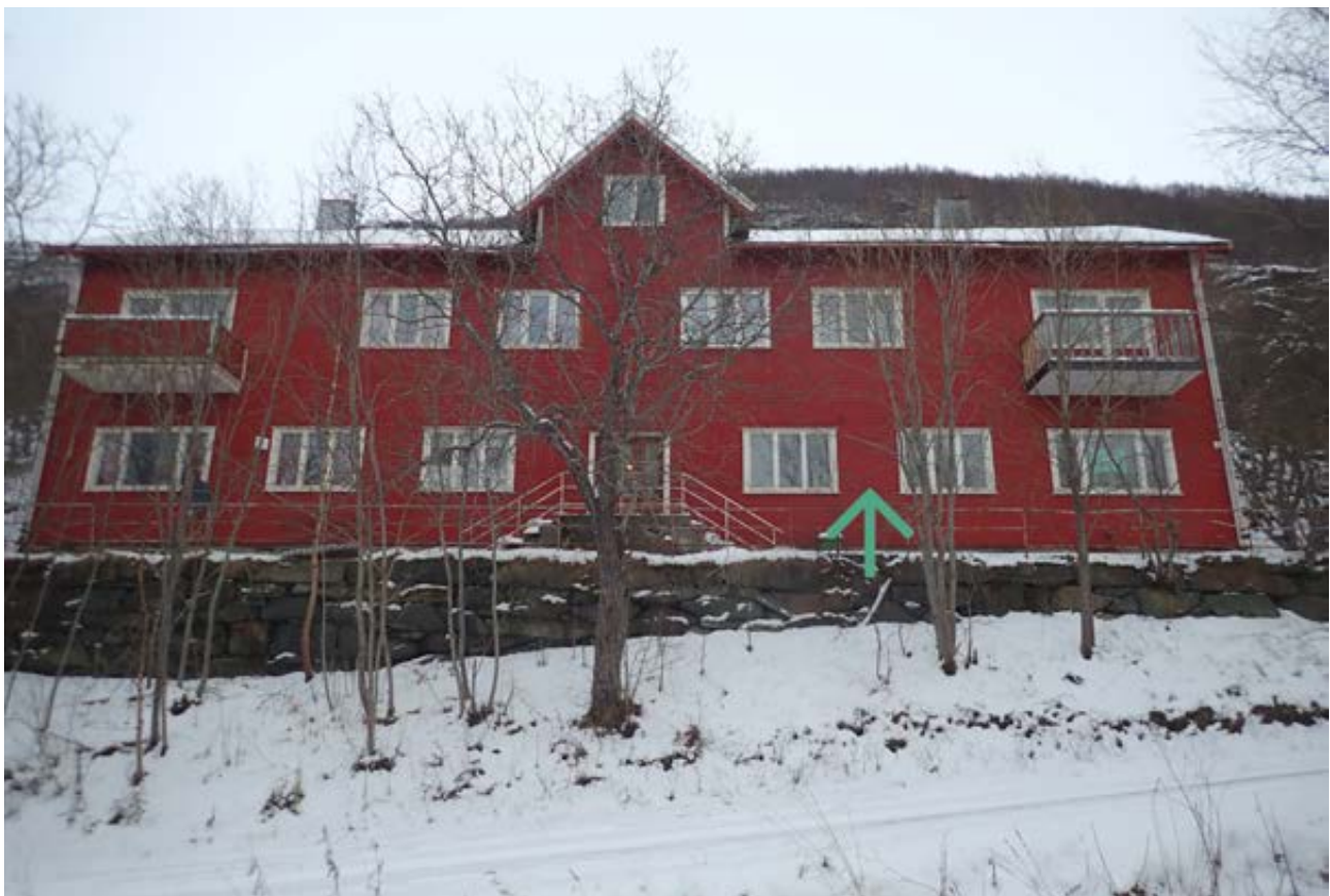
Verkstedhaugen 3 b er i 1 etasje, nede til høyre. Foto: Privat
