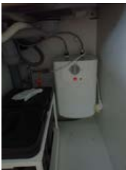
Innredning med vvb i benkskap under oppvaskkum.
