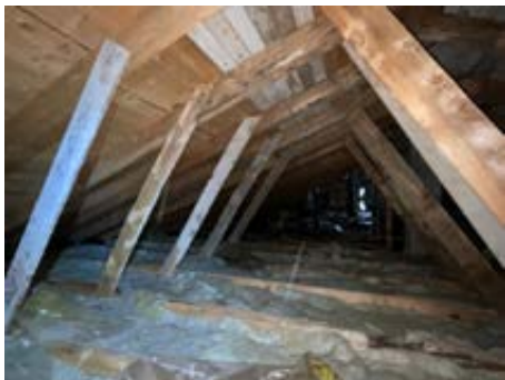
Takkonstruksjon tilbygg stue
