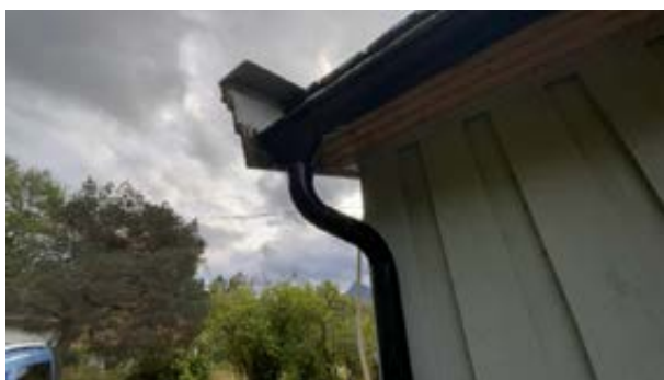
Takrenner og nedløp i stål.
