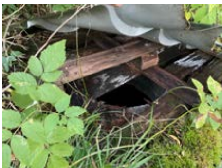
Septiktanken synlig under takplaten.
