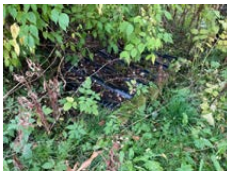
Septiktank skjult under takplate i hagen
