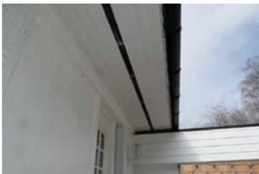
Luftespalter i kassekledning.
