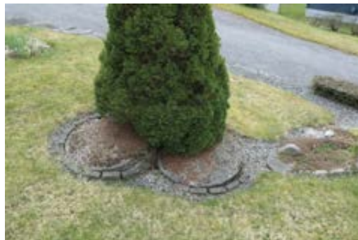
Antas septiktank av betong e.l.
