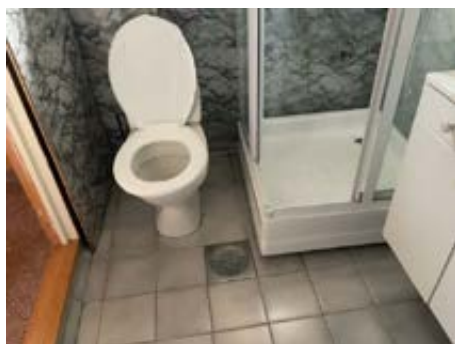
Dusjkabinett og wc i rommet.
