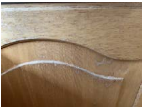
Slitasje på fronter benkeskap.
