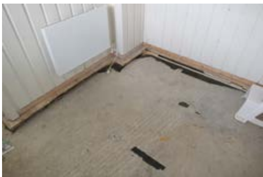
Gulv er fjernet ned til betonggulv.
