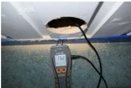
Ikke registrert fukt i vegg soverom på befaringdagen.
