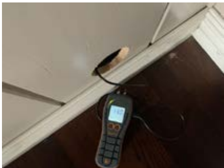
Ikke registrert fukt i vegg med isopor på befaringdagen.
