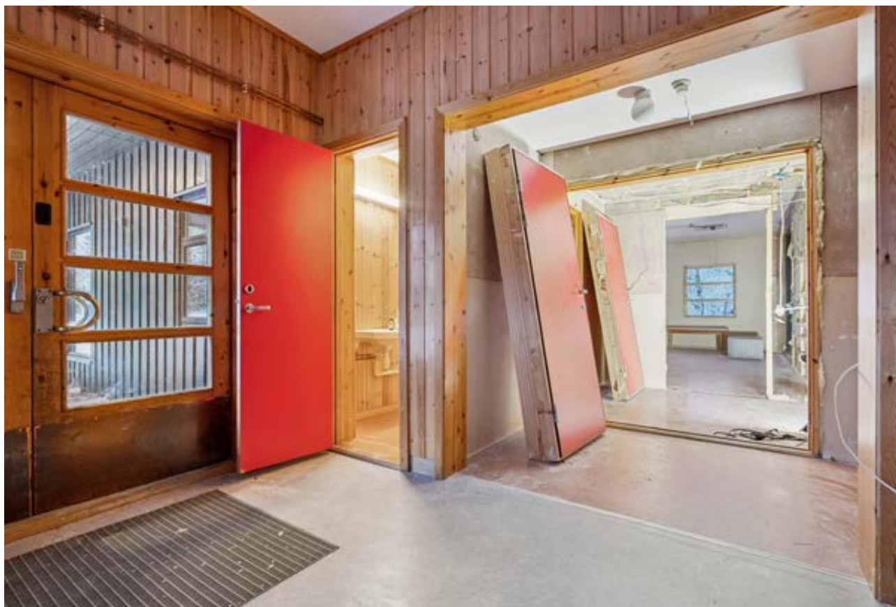
Inngangsparti- under ombygging/renovering til fritidsleilighet
