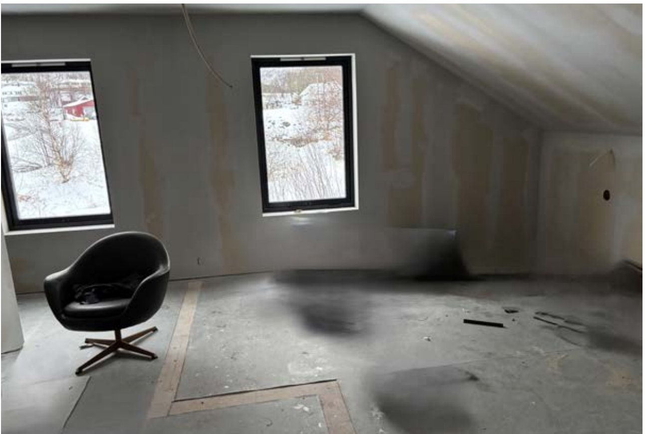
Bilde av soverom i 2 etasjen - under renovering
