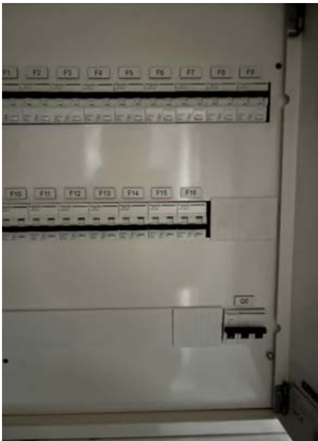
Sikringsskapet under arbeid- ikke ferdigstilt
