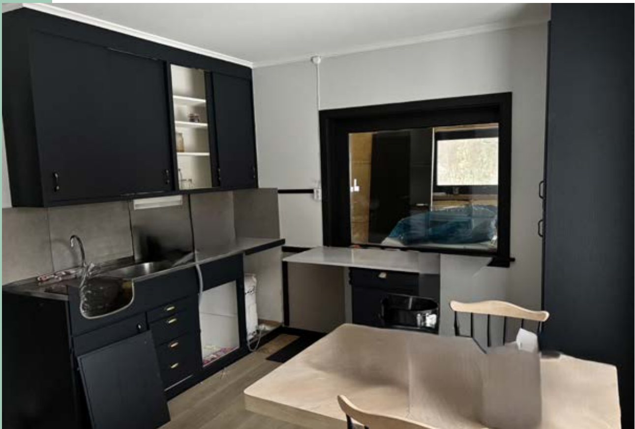
Kjøkken under renovering.jpg
