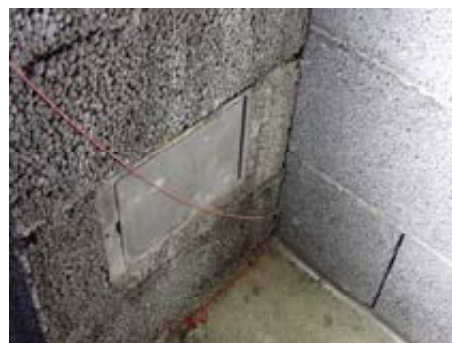
Sotluke underetasje
