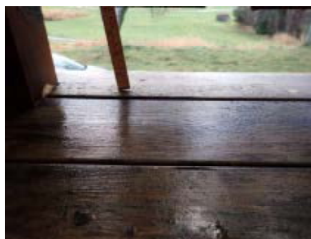
For stor åpning i rekkverk
