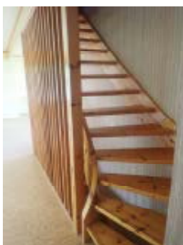
Trapp til 1 etasje mangler håndløper på vegg
