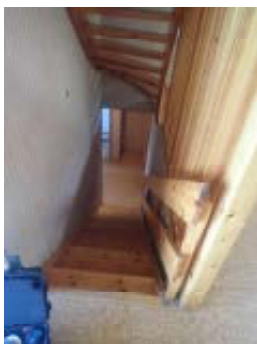
Trapp til 1 etasje mangler håndløper på vegg
