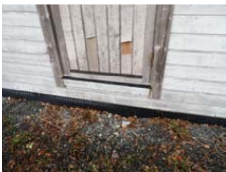
Skader i vaskeromsdør
