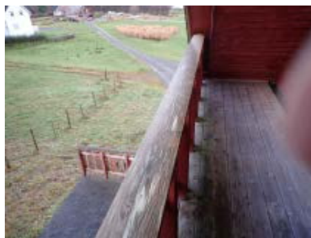
For stor åpning i rekkverk
