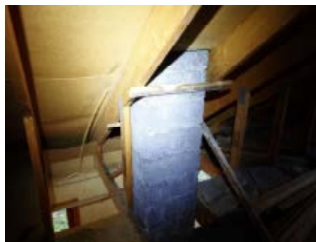
Revet kledning/isolasjon rundt pipe
