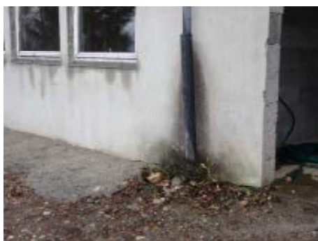
Taknedløp avsluttet over bakkenivå
