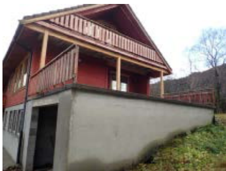
Rekkverk mangler
